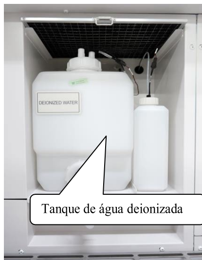
Figura 11.5 Tanque de água deionizada
